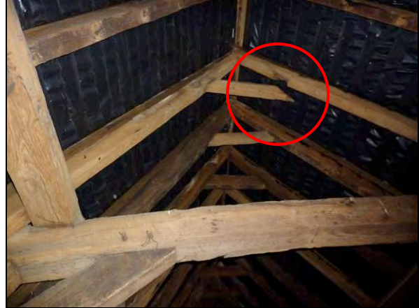
Dit spant hangt los in de nok.
