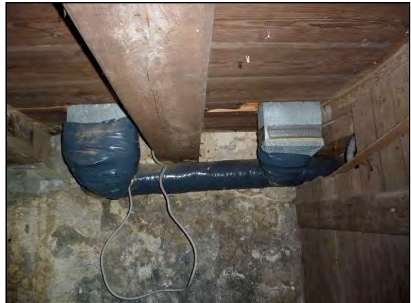
De luchtbehandeling is gemonteerd in de kelder.
