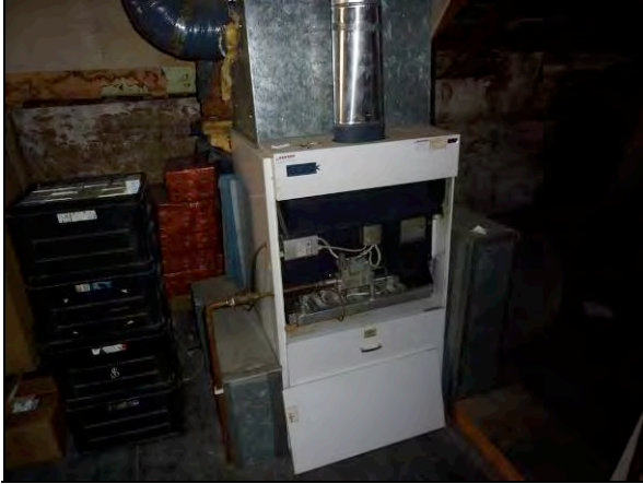
Beide cv ketels dateren uit 1986 en dienen op korte termijn vervangen te worden.
