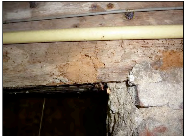
Houtworm en vermolmd hout.
