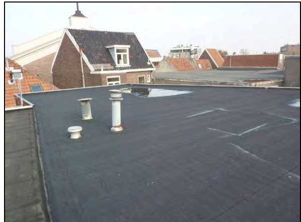
Het grootste platte dak heeft nieuwe dakbedekking.
