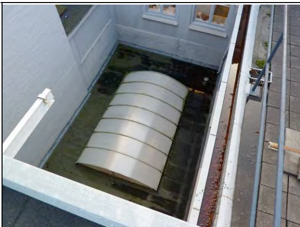
De dakranden verkeren in goede conditie evenals de overige dakbedekking.
